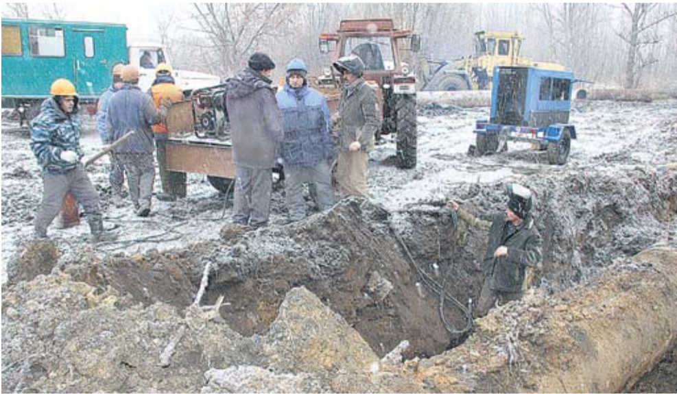
Подготовка к ремонтным работам
