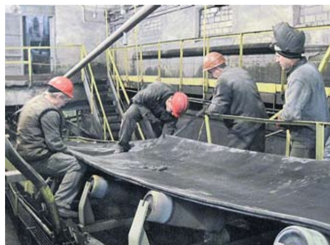
Момент замены конвейерной ленты
